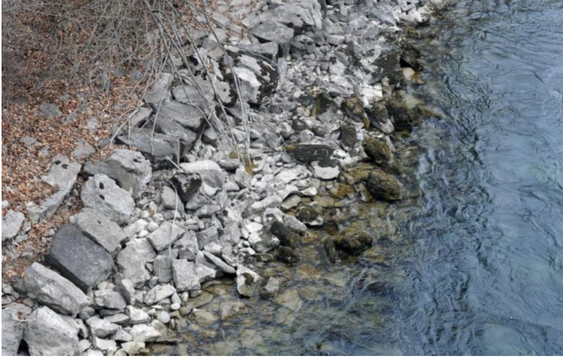
Unterspülte Natursteinpflasterung (Bild: TBA)
