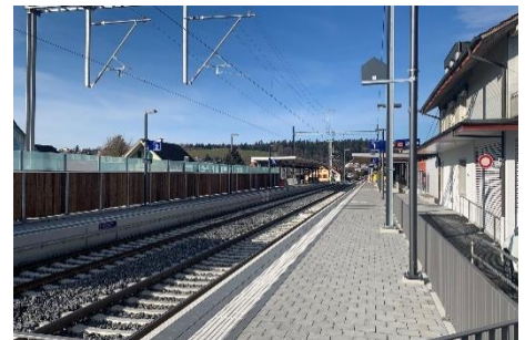
Neue Perronanlagen Bhf Heimberg
