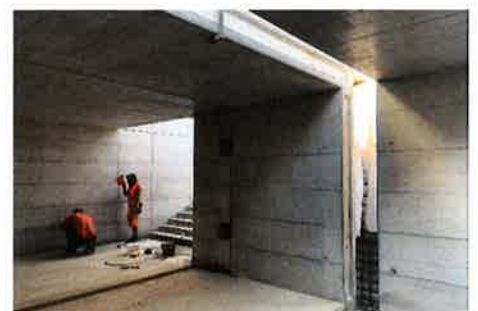
Neue Personenunterführung mit Blick zur Treppé zu Perron 2
