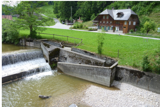
Abbildung 9: Beispiel einer Fischaufstiegsanlage bei einer Sperre (Rötebach in Eggiwil).
