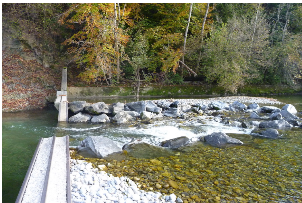
Abbildung 14: Beispiel einer Schwelle mit Kranz, Emme bei Schüpbach.
