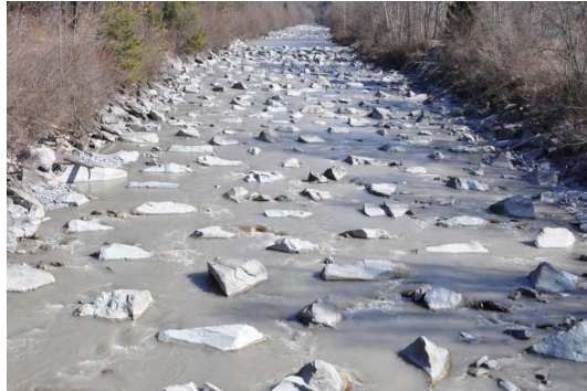
Abbildung 8: Beispiel einer aufgelöste, unstrukturierte Blockrampe (Landquart GR, Blick gegen Fliessrichtung; Quelle VAW).
