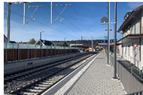
Neue Perronanlagen Bahnhof Heimberg
