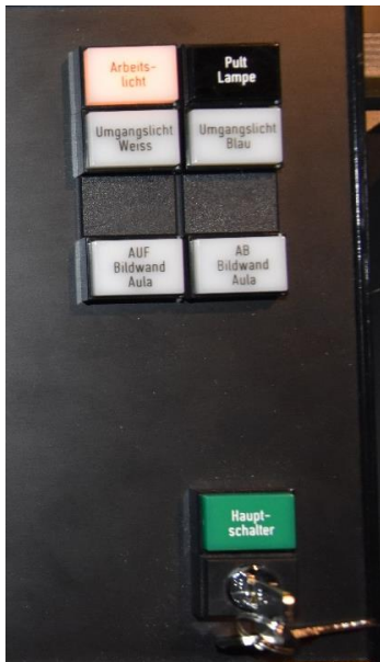
Hauptschalter für das Einschalten der gesamten AULA Steuerung.
