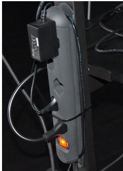
Steckdosenleiste als Hauptschalter für das Einschalten des Audiomischpults und des Lichtsteuerpults.
