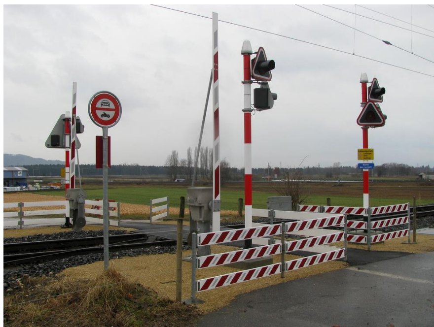
Abb. 5: Beispiel für einen Bahnübergang für Fussgänger (BÜ Bandrain km 29.077)
